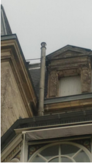
Extérieur : sur la toiture
